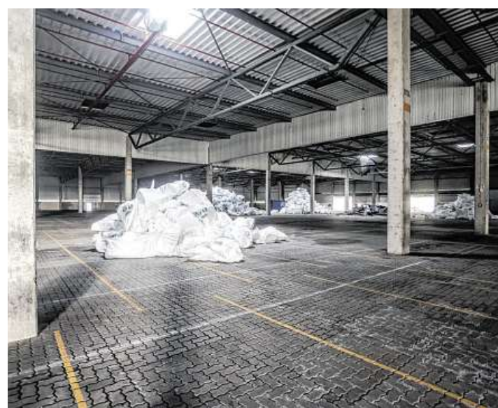
Säckeweise Sondermüll: In einer Halle stapeln sich Berge alter Mineralwolle.
