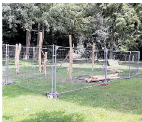
Ein Balancier- und Kletterparcours entsteht im Stadtgarten Vegesack. FOTO: BJÖRN JOSTEN
